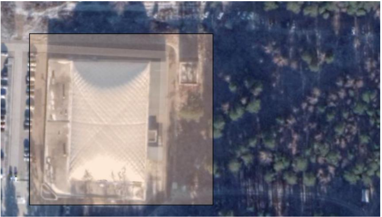
Рисунок 14. Зона действия котельной ФОК «Айсберг» ООО «ДОМ».
